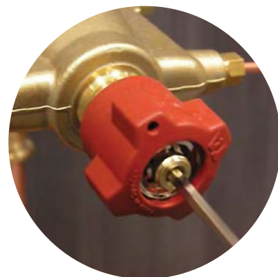
Einstellung des Sollwertes mit einem 3 mm Inbusschlüssel
